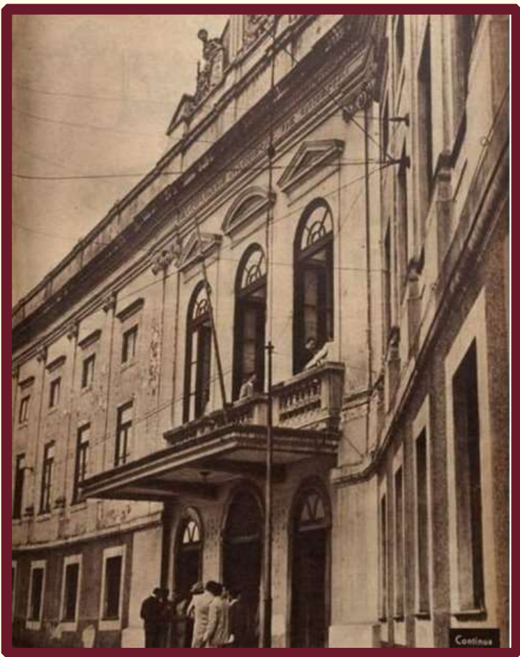
Imagem 29 – Prédio da FND antes da reforma de ampliação
