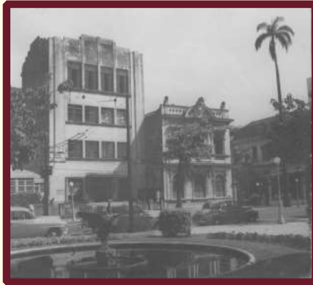
Imagem 23 – Antigo Prédio da FGV
