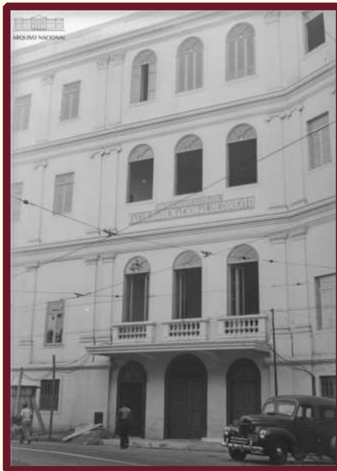
Imagem 30 – Fachada da FND em 1949 após a reforma predial de ampliação
